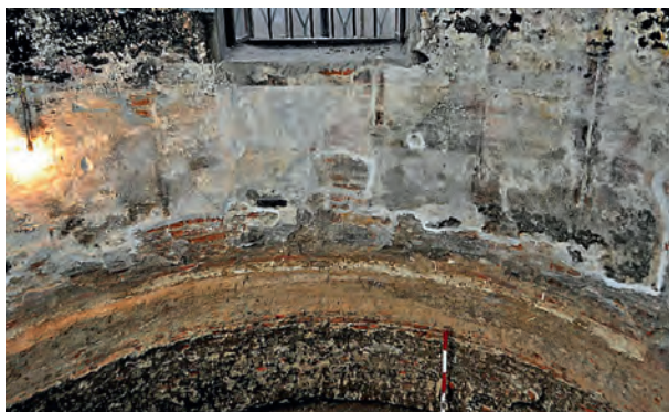
Zidul, centura și fundația absidei sudice
